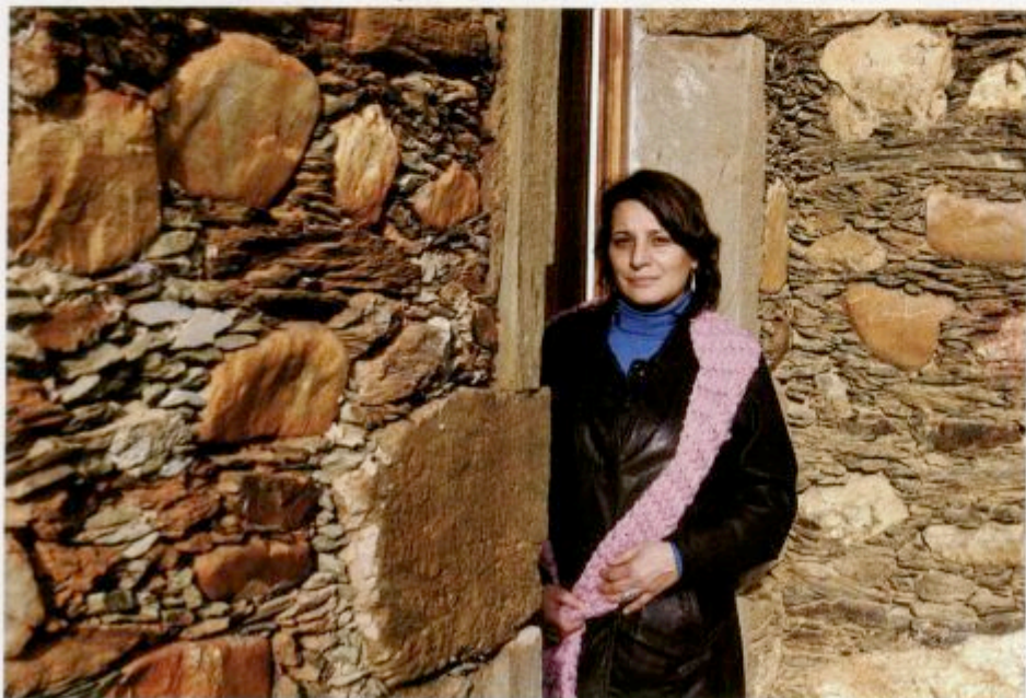
ANA CUNHA junto a uma das 50 casas de Janeiro de Cima recuperadas, cujas paredes têm a particularidade de serem uma mistura de seixos do rio com xisto
